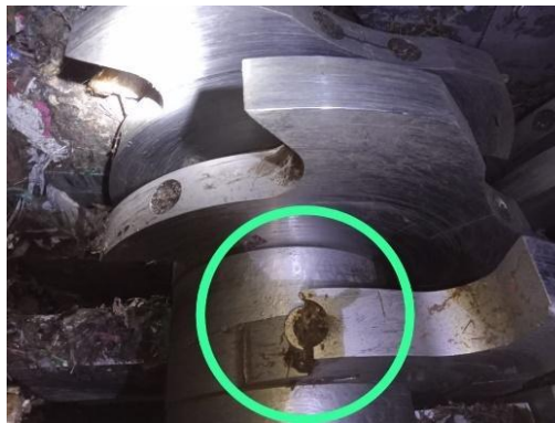
Gambar I.4 Kondisi Rotary knife yang Patah
